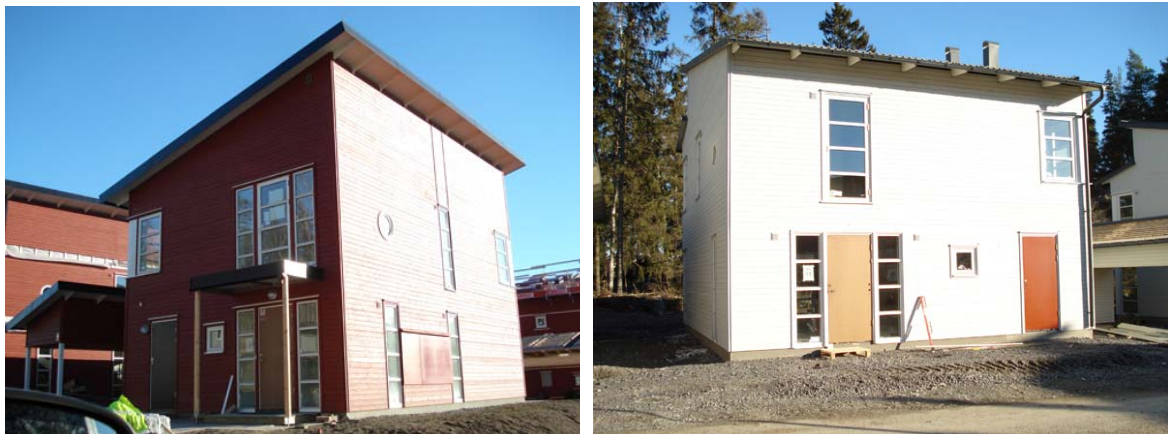
Figur 8. Fotografier av testhusen, 12 och 22, med styrd ventilation.
